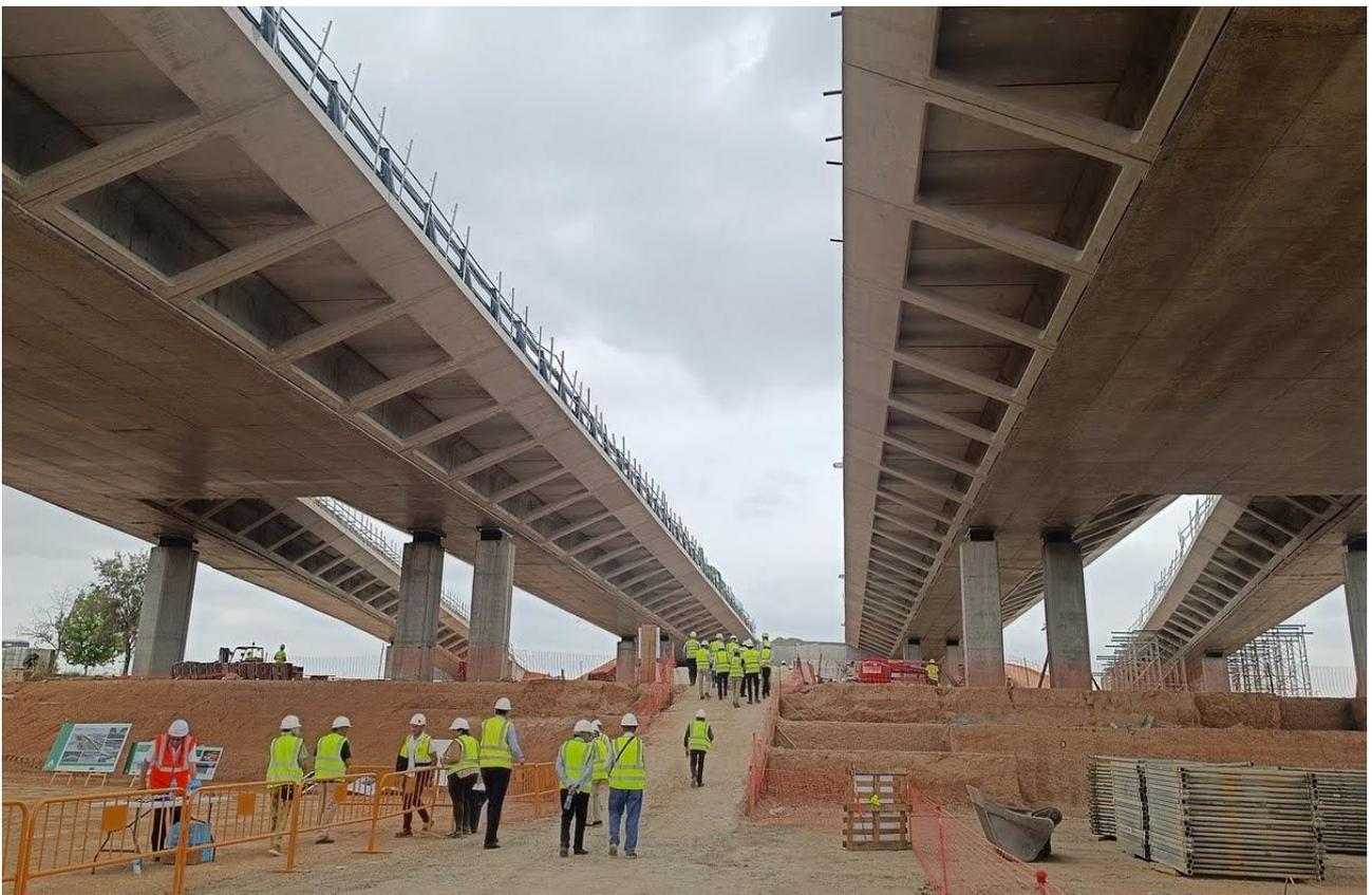
La viga central del viaducto norte ya está terminada en ambas calzadas, mientras que en el viaducto sur está terminada en la calzada izquierda y muy avanzada en la derecha. Actualmente, se está trabajando en la colocación y montaje de **jabalcones en ambos viaductos**: se han ejecutado en la práctica totalidad del viaducto sur y una parte del
