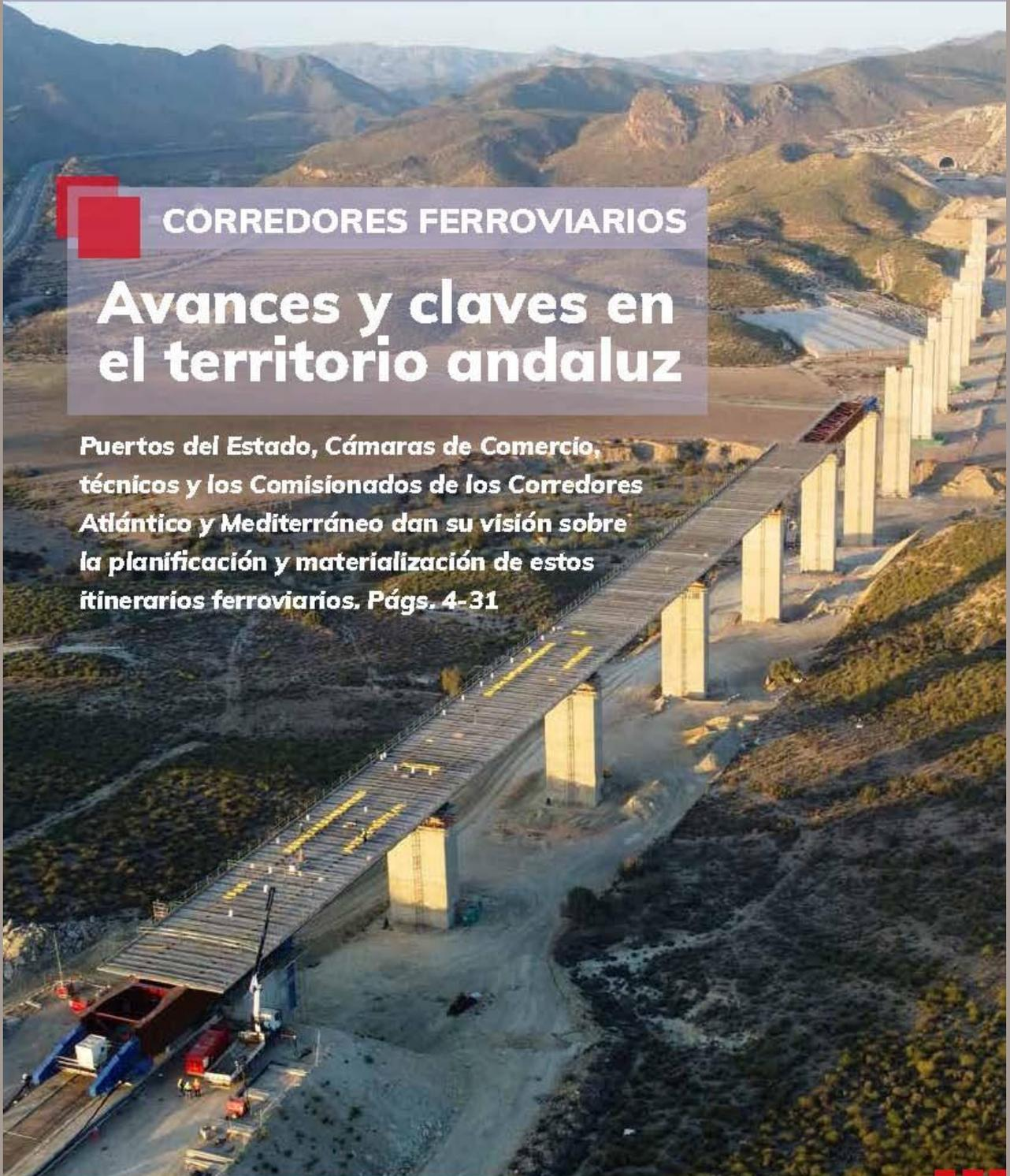
Fotografía cortesía de la Dfda de del Comisionado del Corredor Mediterráneo: Tramo de las obras en Los Arejos (Murcia)-Níjar (Almería) - Lanzamiento del Viaducto de Los Feos.
