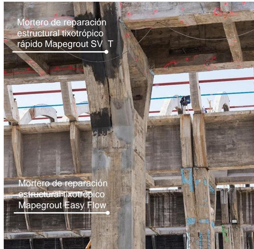
Mortero de reparación estructural tixotrópico rápido Mapegrout SV T
