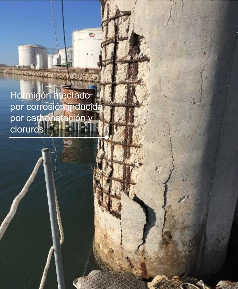
Hormigón afectado por corrosión inducida por carbonatación y cloruros
