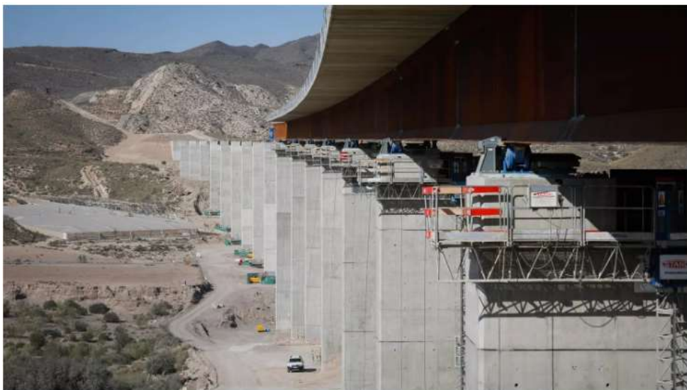
Construcción del viaducto de Los Feos, en la línea de la Alta Velocidad / MARIAN LEÓN
