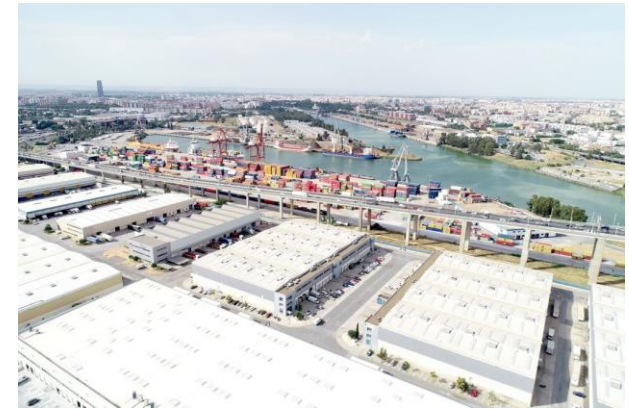
ZAL del puerto de Sevilla
