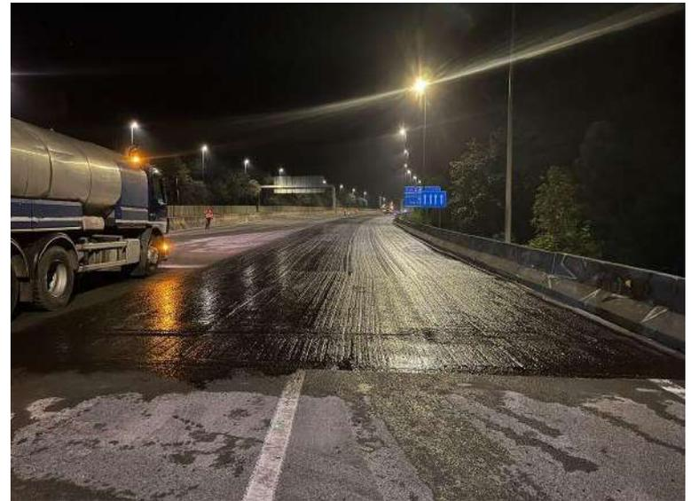
DESPUES DEL SECADO DE LA EMULSION SE PROCEDE CON LA COLOCACION DE LA GEOMALLA DE REFUERZO POR TERMOFUSIÓN.
