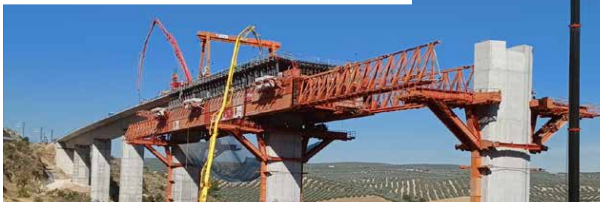
Viaducto de Río Frío de la LAV Antequera-Granada.
