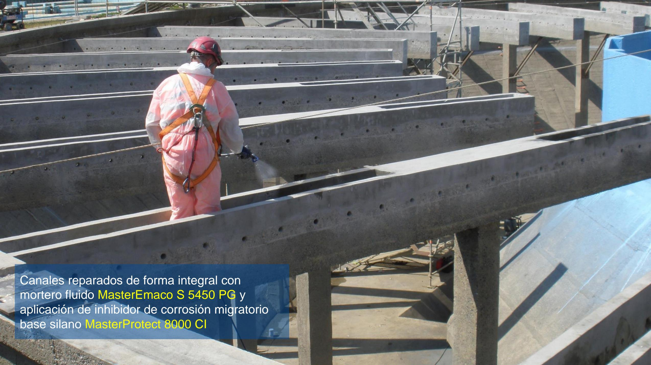
Canales reparados de forma integral con mortero fluido **MasterEmaco S 5450 PG** y aplicación de inhibidor de corrosión migratorio base silano **MasterProtect 8000 CI**
