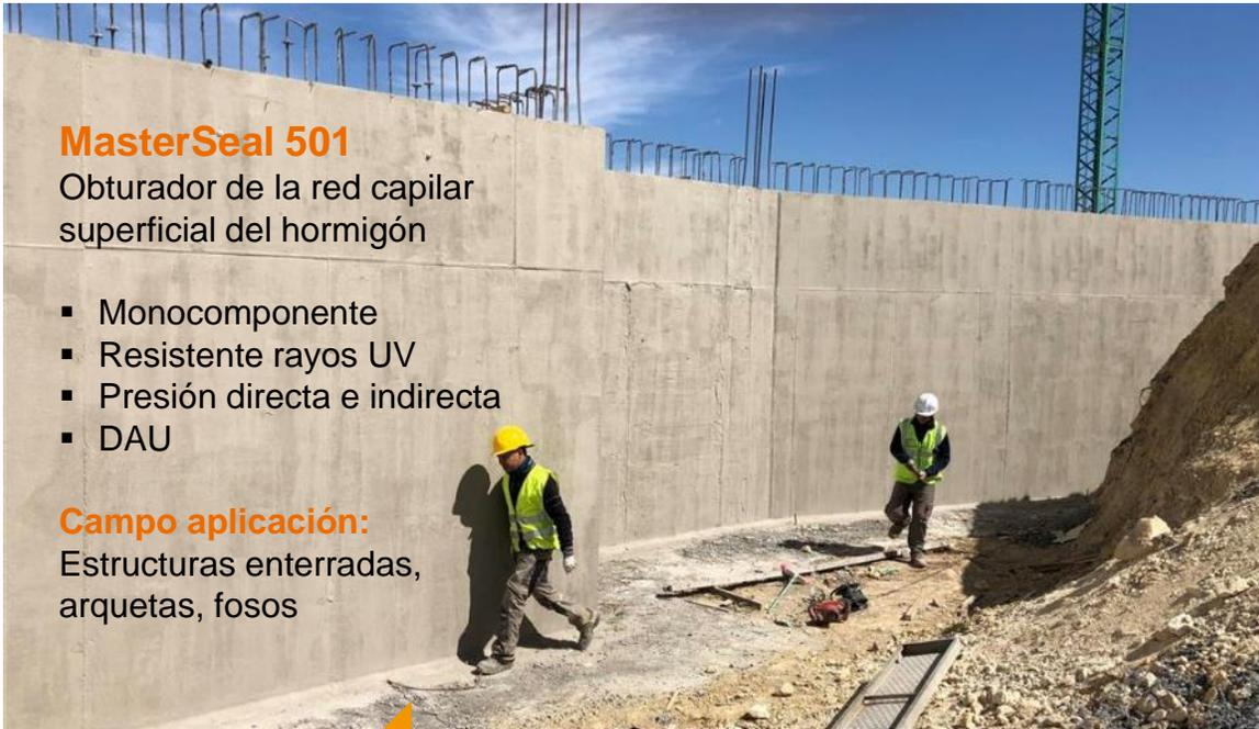
Membranas cementosas rígidas
