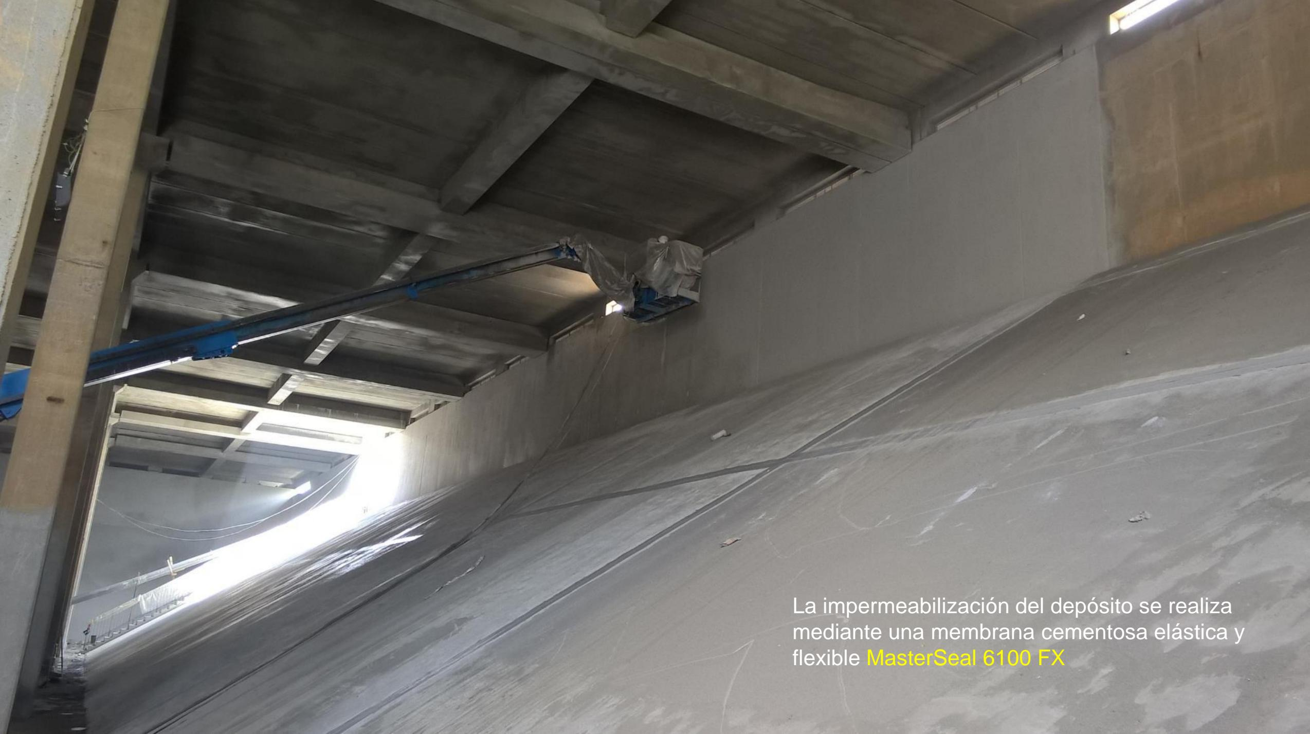
La impermeabilización del depósito se realiza mediante una membrana cementosa elástica y flexible **MasterSeal 6100 FX**
