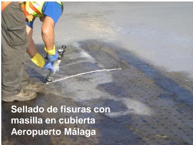
Sellado de fisuras con masilla en cubierta Aeropuerto Málaga
