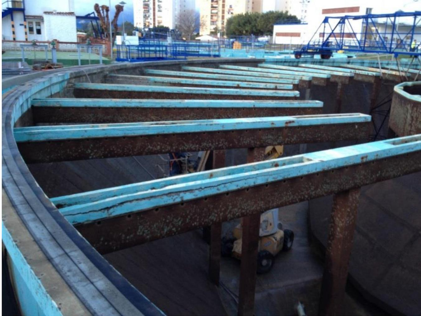
El proyecto contemplaba la reparación de las zonas más afectadas, el sellado de las juntas y la impermeabilización y protección de los paramentos.
