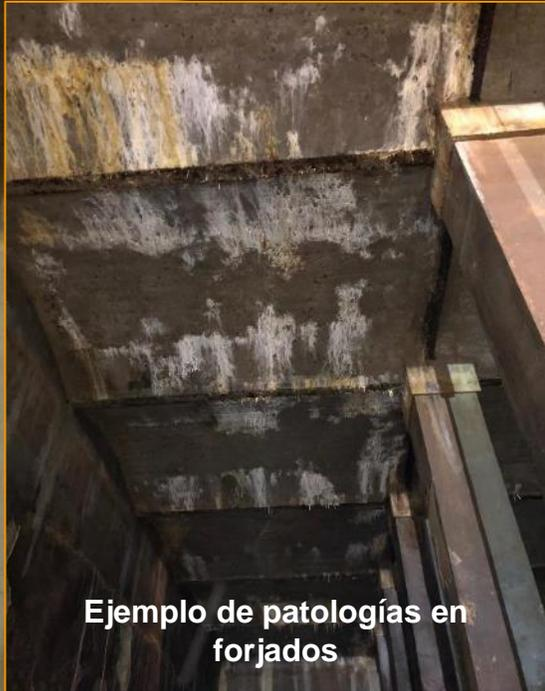
Se plantea como solución el tratamiento de las placas de hormigón prefabricado del forjado mediante un mortero impermeable cementoso rígido **MasterSeal 531**
