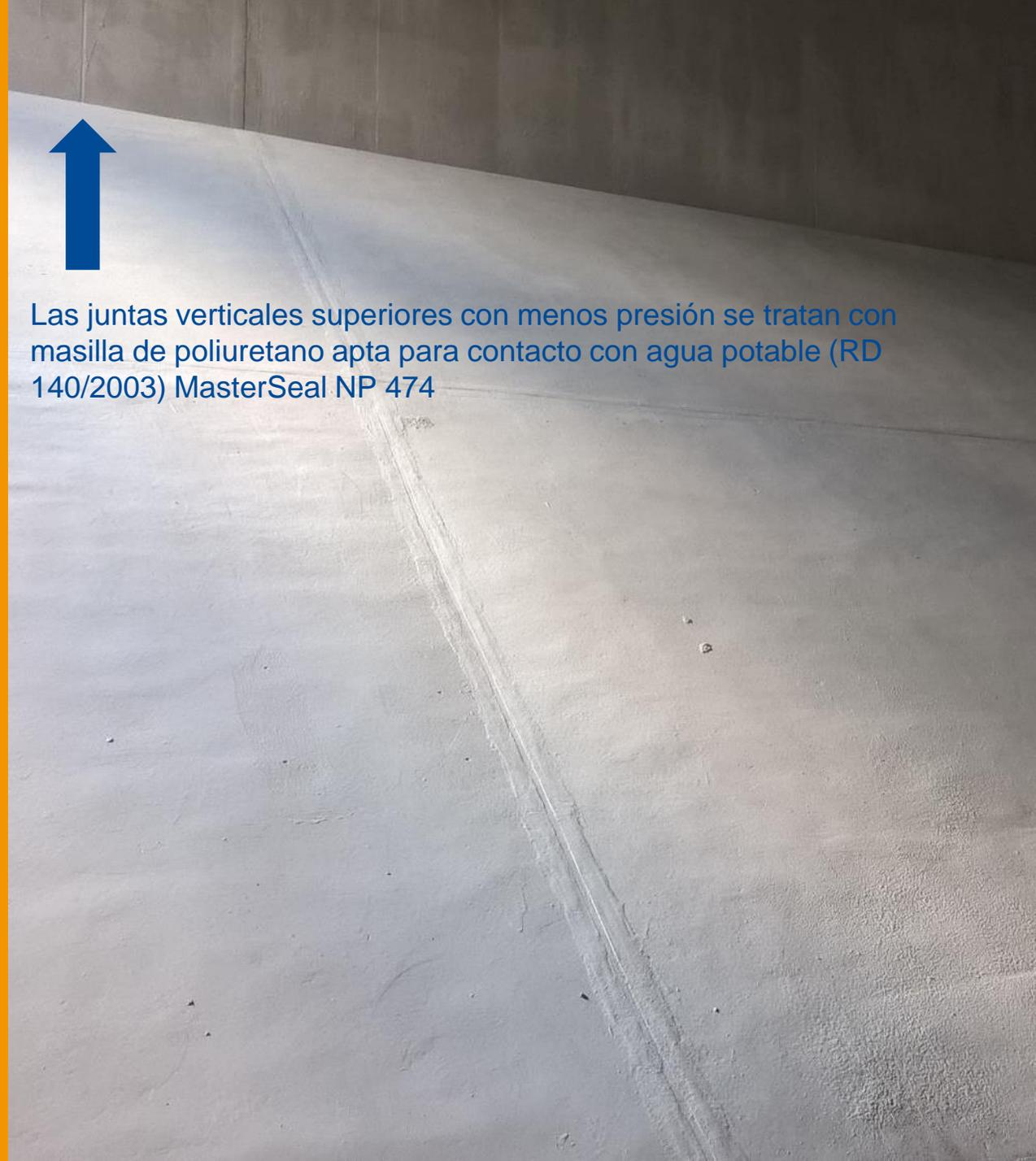
Las juntas verticales superiores con menos presión se tratan con masilla de poliuretano apta para contacto con agua potable (RD 140/2003) **MasterSeal NP 474**
