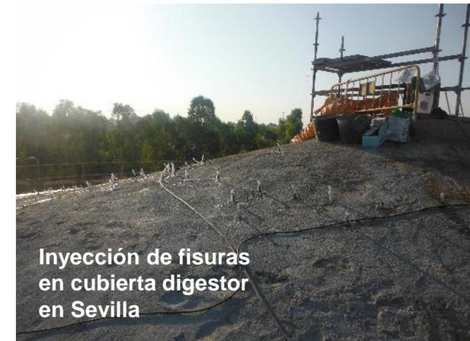
Inyección de fisuras en cubierta digestor en Sevilla
