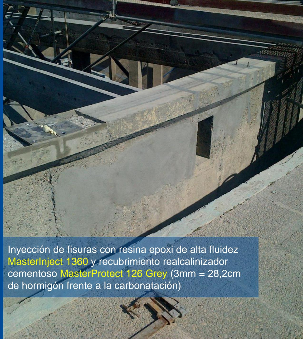
Inyección de fisuras con resina epoxi de alta fluidez **MasterInject 1360** y recubrimiento realcalinizador cementoso **MasterProtect 126 Grey** (3mm = 28,2cm de hormigón frente a la carbonatación)
