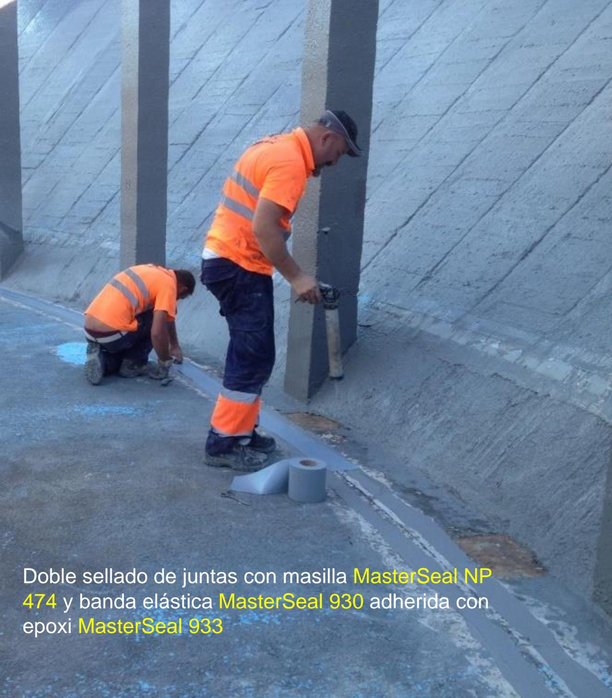
Doble sellado de juntas con masilla **MasterSeal NP 474** y banda elástica **MasterSeal 930** adherida con epoxi **MasterSeal 933**
