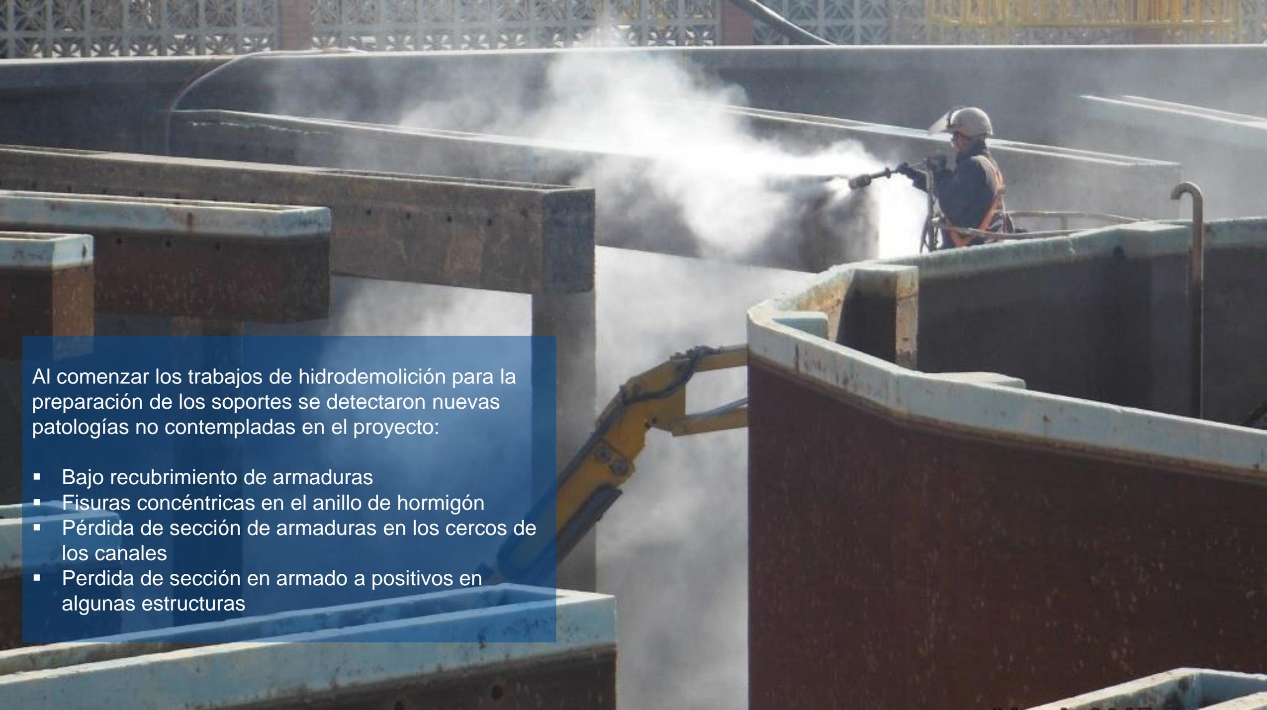
Al comenzar los trabajos de hidrodemolición para la preparación de los soportes se detectaron nuevas patologías no contempladas en el proyecto:
