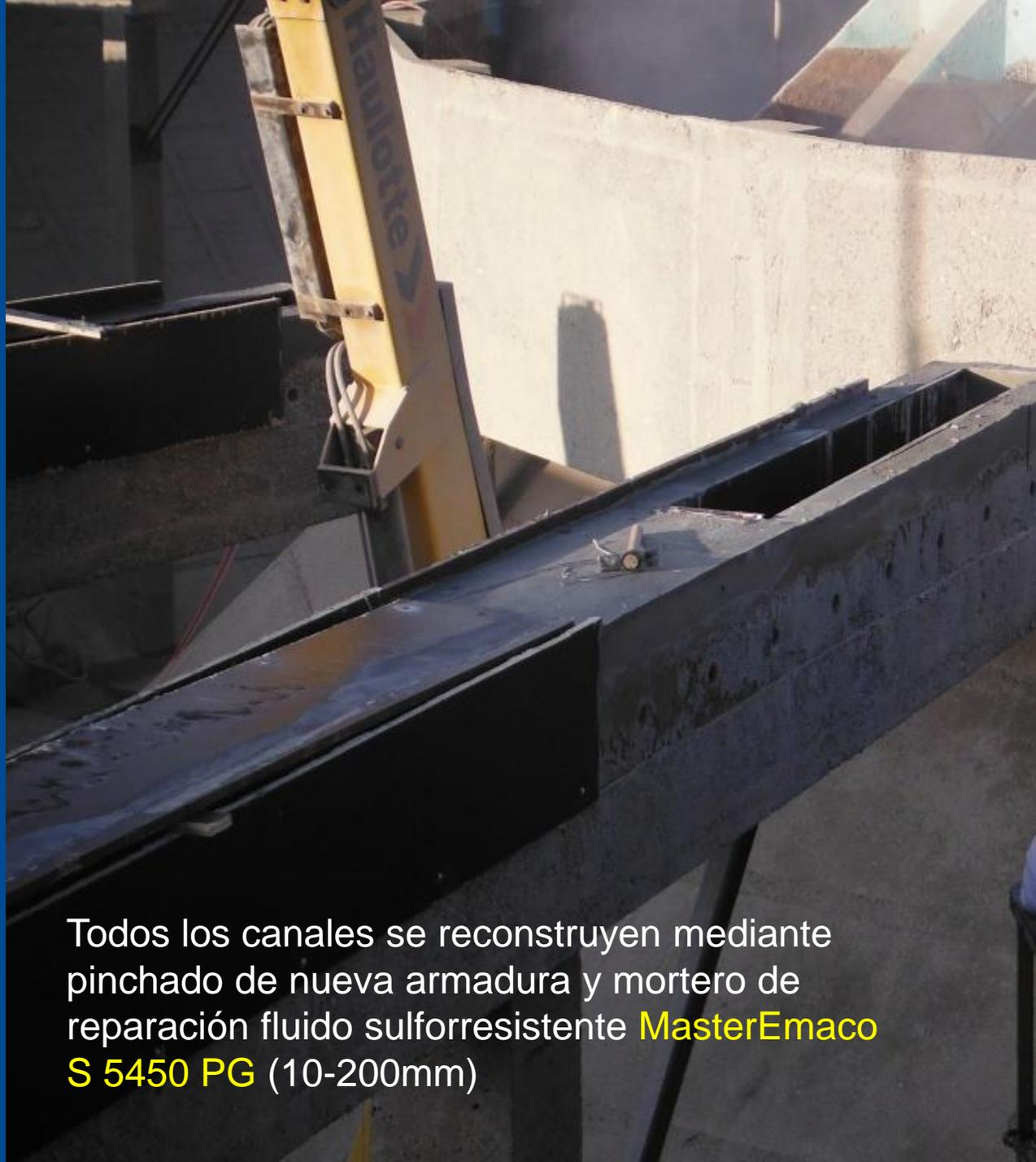
Todos los canales se reconstruyen mediante pinchado de nueva armadura y mortero de reparación fluido sulfurresistente **MasterEmaco S 5450 PG** (10-200mm)
