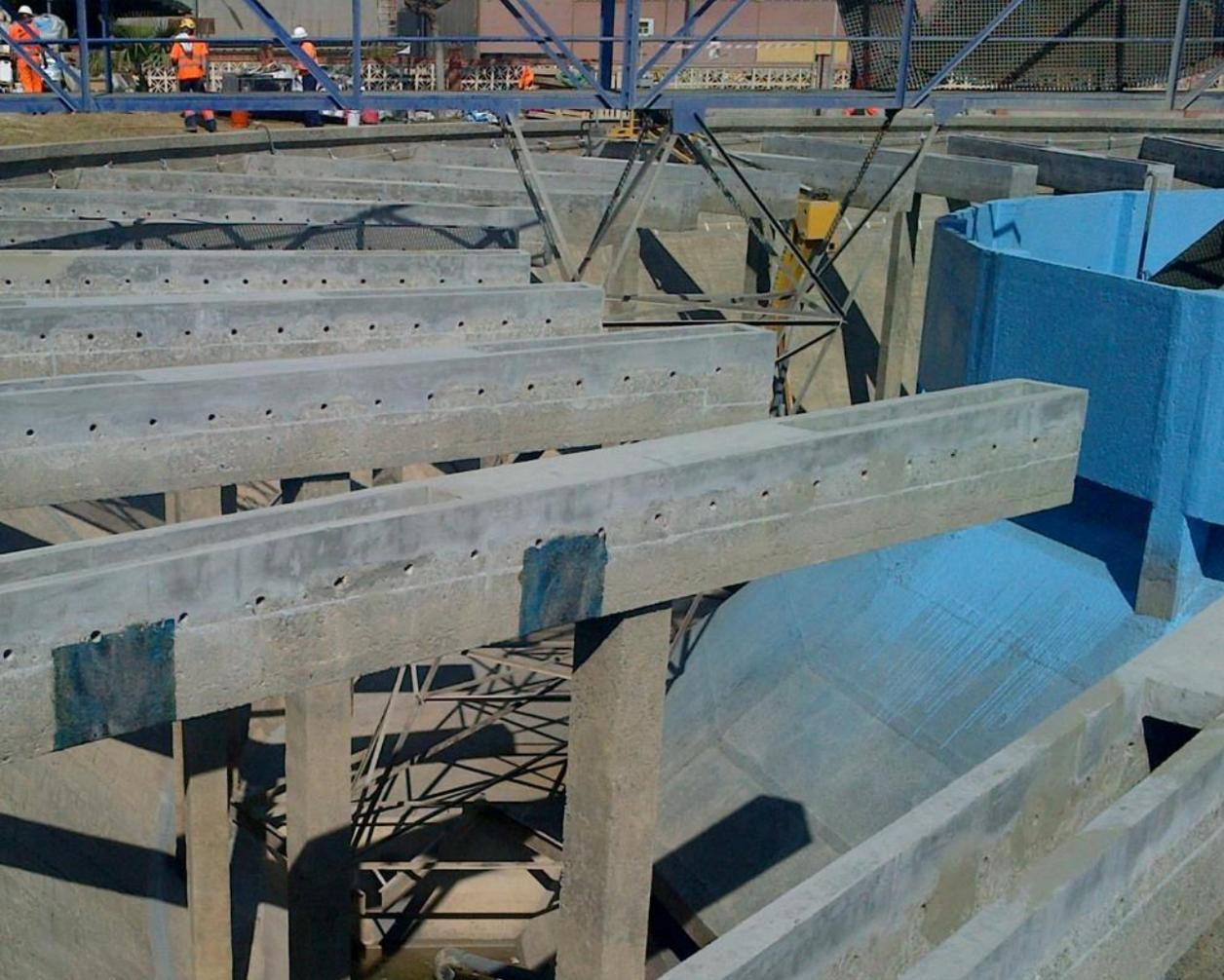
Refuerzo estructural con hoja de fibra de carbono **MasterBrace FIB** y refuerzos a positivos con laminados **MasterBrace LAM**
