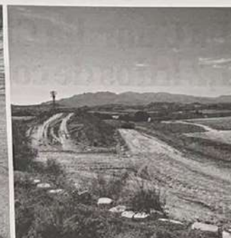
LEVANTE Detalle de movimiento de tierras para la plataforma del AVE entre Vera y Pulpí.
