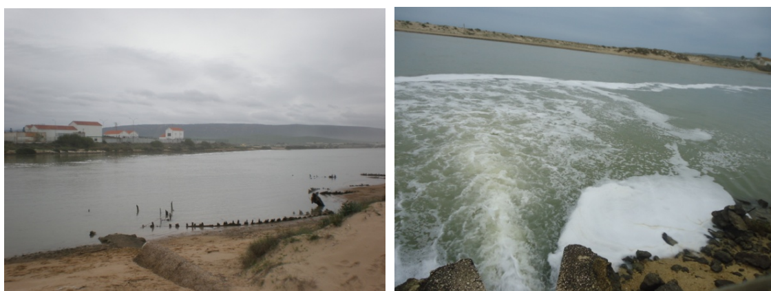
Barbate. Vertido de EDAR en desembocadura Río Barbate.
