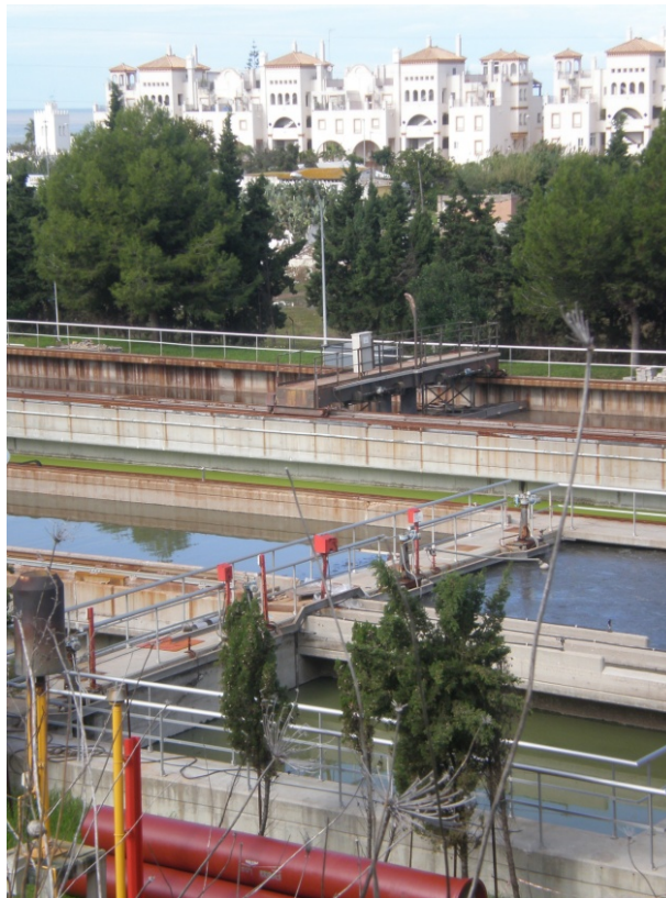
EDAR Sanlúcar de Barrameda -Muy mal funcionamiento
