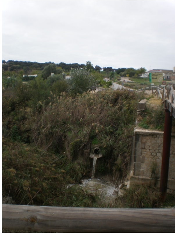
San José del Valle Vertido directo de colector al Arroyo "Los Toreros"
