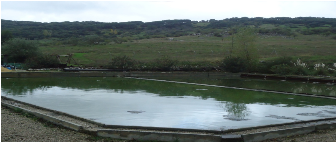
Depuradora de Grazalema- Obsoleta
