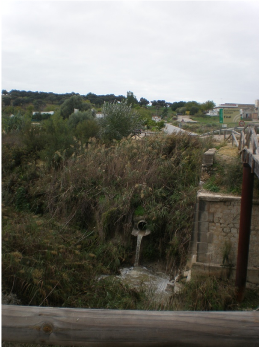
San José del Valle. Vertido directo desde el colector al arroyo "Los Toreros" sin ningún tipo de tratamiento ni depuración
