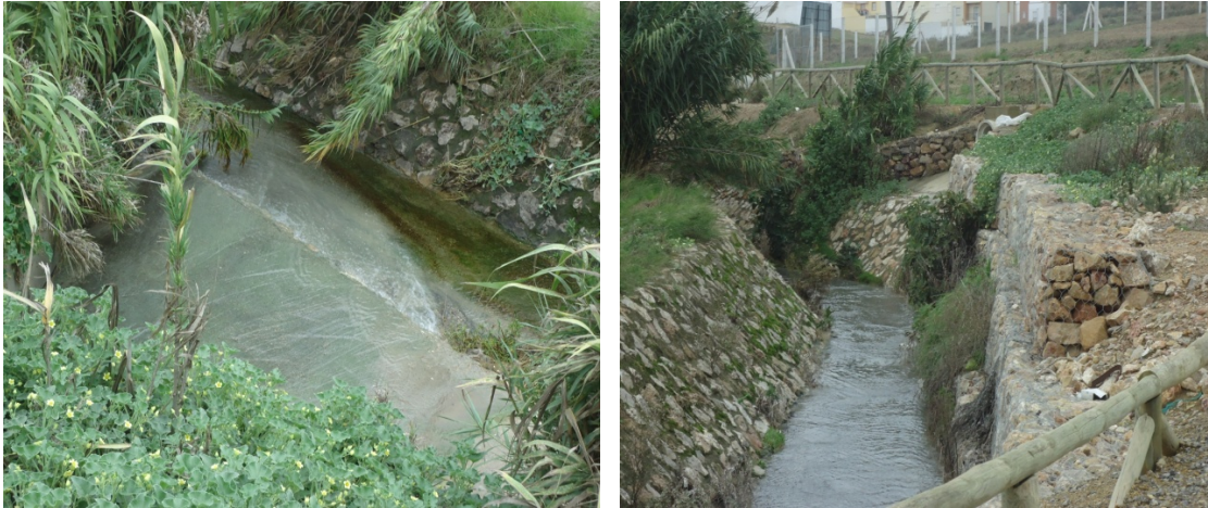
Vertido a acequia de Trebujena
