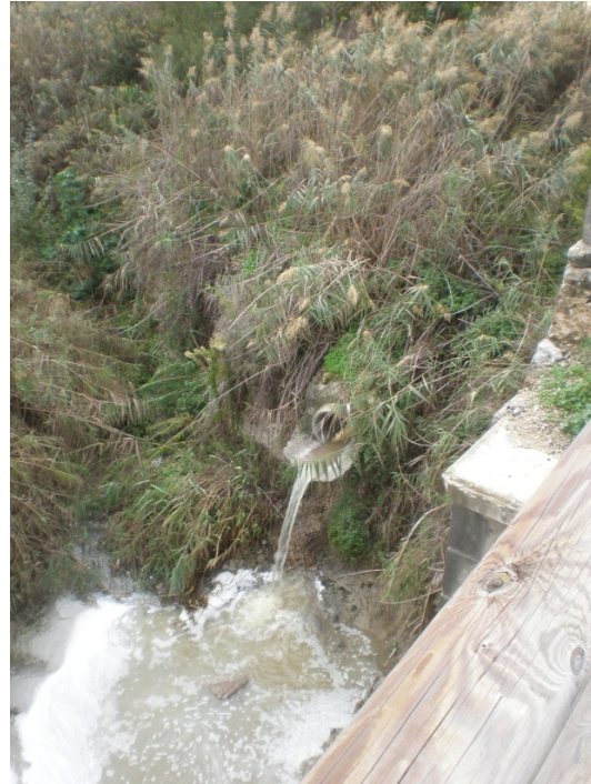
San José del Valle. Vertido directo desde el colector al arroyo "Los Toreros" sin ningún tipo de tratamiento ni depuración
