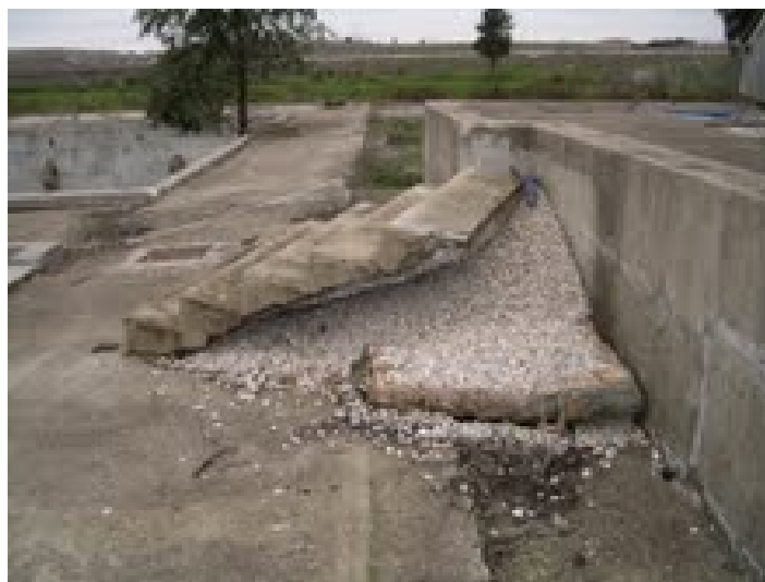
EDAR de Jédula, en Arcos de la Frontera. Abandonada.
