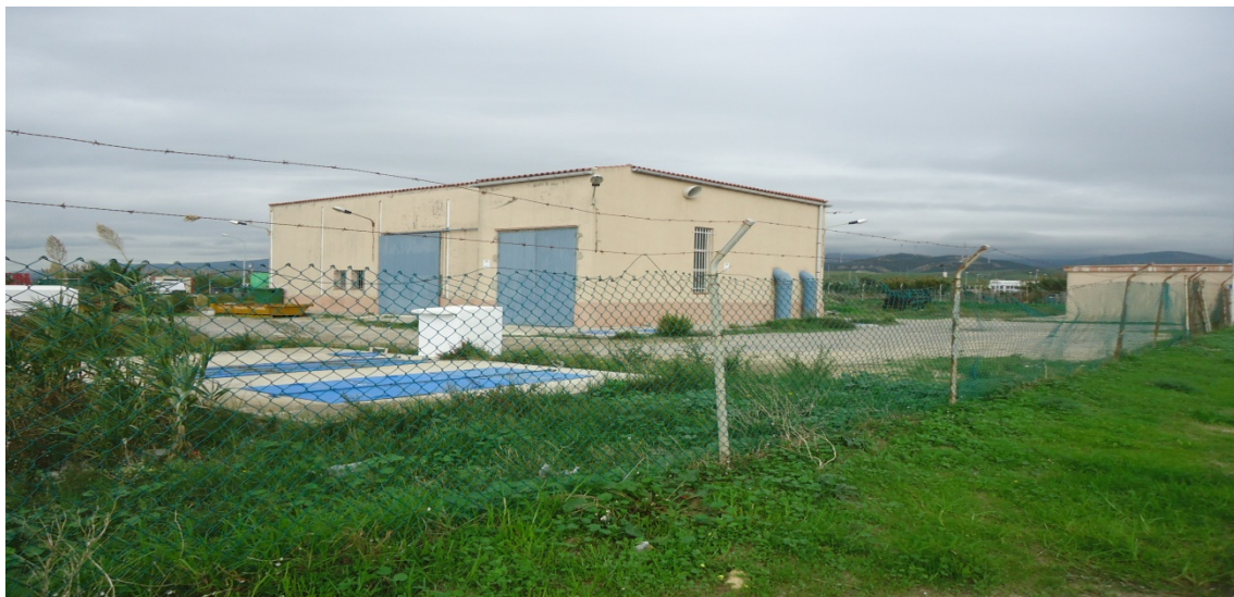
Planta de Pretratamiento en Tarifa- Sólo existe pretratamiento
