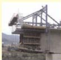
EJECUCIÓN DE PUENTES
