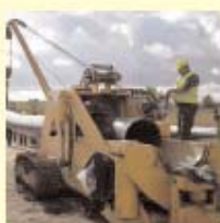
EXCAVACIONES, VOLADURAS Y MOVIMIENTO DE TIERRAS
