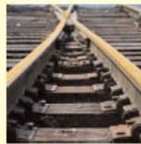
CONSTRUCCIÓN DE INFRAESTRUCTURAS FERROVIARIAS
