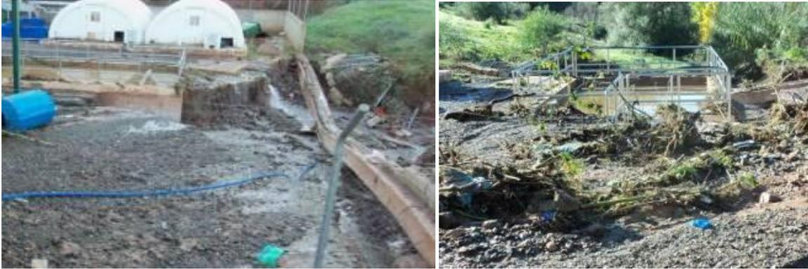
*Daños observados en diferentes elementos de la planta: cerramientos, pretratamiento, biodiscos, decantador, etc.*
