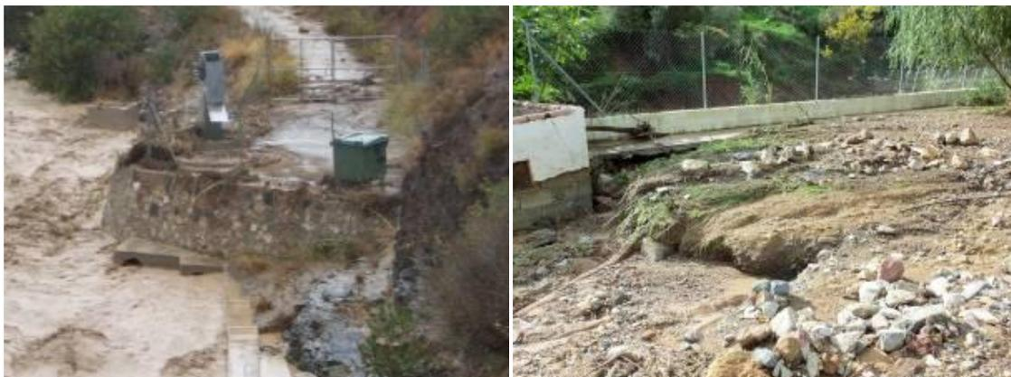
*Obra de Llegada Aterramientos en la planta*
