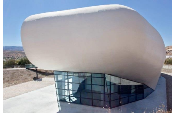
Sede del Clúster de la Construcción Sostenible. El Padul
