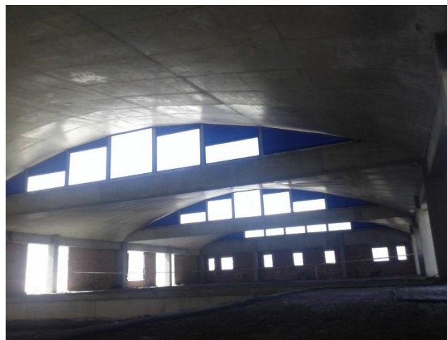
Cubierta Terminal de Pasajeros del Puerto de Motril, Motril
