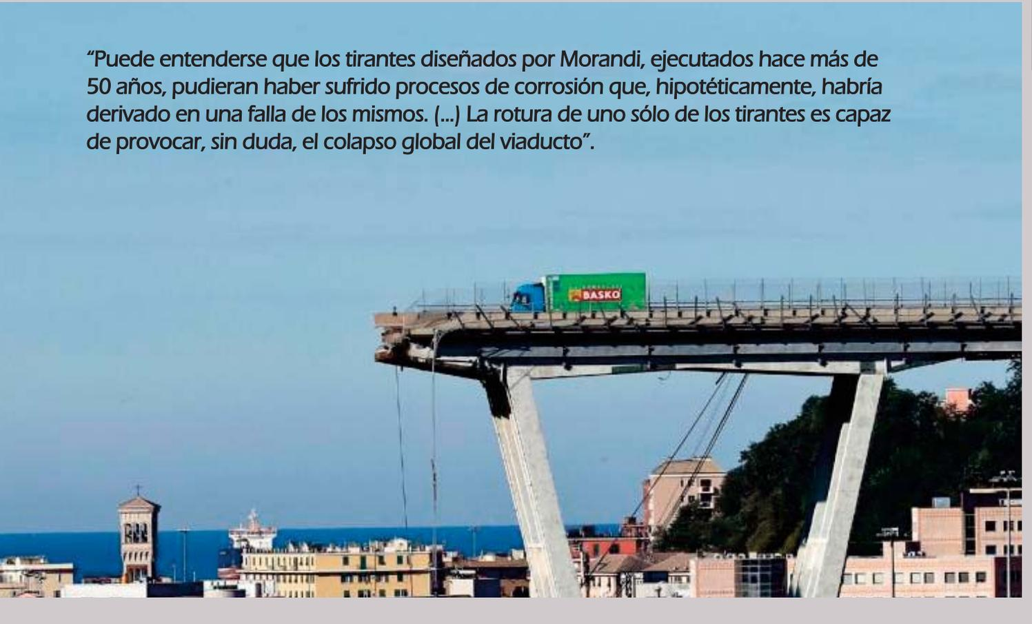
magnitud de la reacción estabilizadora que proporciona la fuerza del tirante que su desaparición aumentaría casi en cinco veces los esfuerzos en el tablero, aparte de que el pilono sería incapaz de resistir el desequilibrio de fuerzas horizontales derivado de la ausencia del tirante. Los efectos dinámicos de la rotura generarían además un efecto negativo multiplicador. Irremediablemente la pila y tableros directamente asociados al supuesto tirante fallido se desplomarían.
