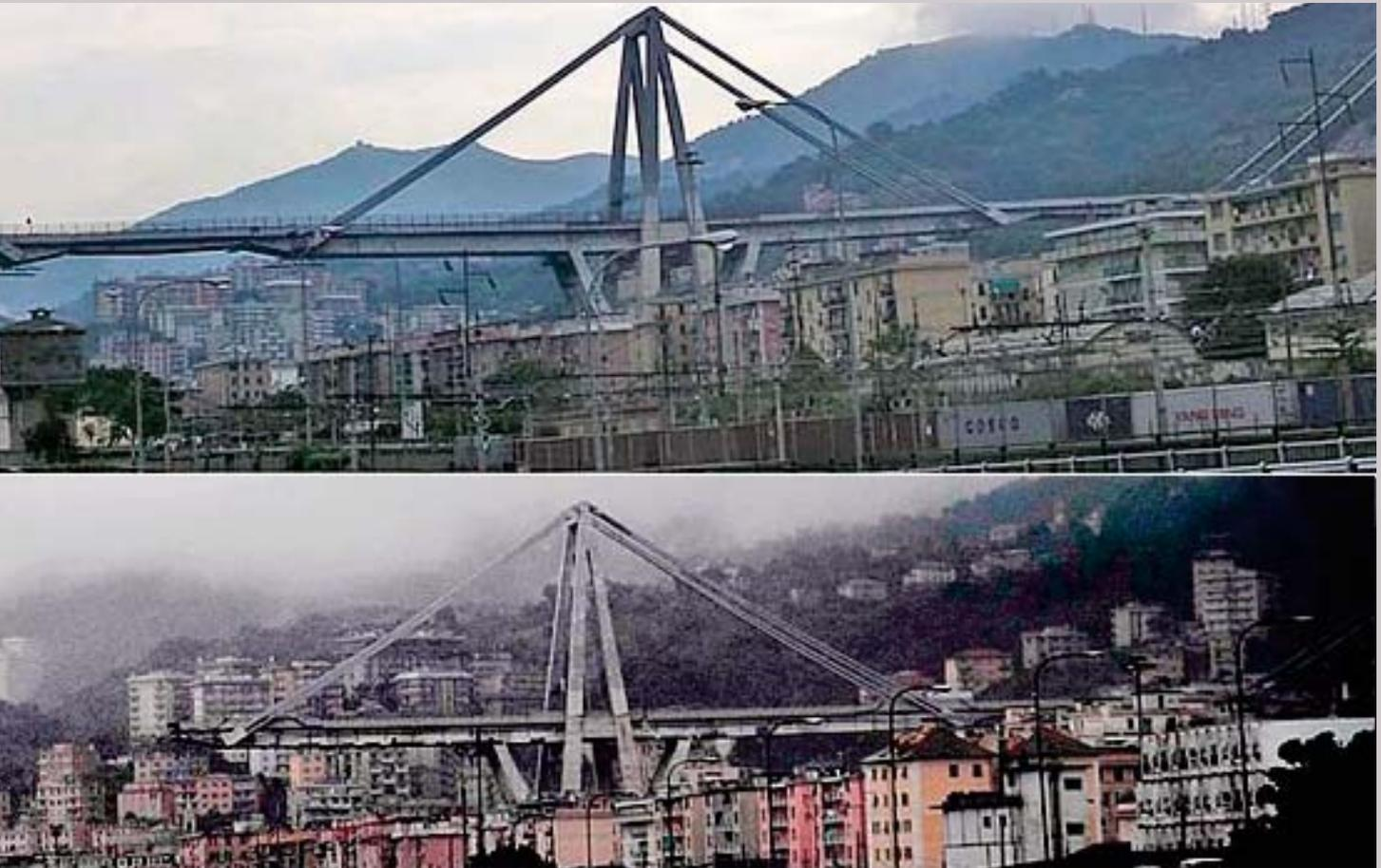
cauce sustituyéndolos por un vano del triple de longitud, gracias a unos tirantes de acero.
