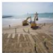
36.- Paso de tubería Sta María del Mar
