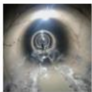
34.- Obra Tubería entre Presa de Charco Redondo
