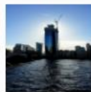
24.- Construction a la orilla del Tâmesis
