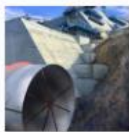
14.- Almenas de hormigón
