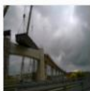
2.- Viaducto del AVE, izado
