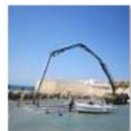
35.- Hormigonado cajones muelle S.Petri
