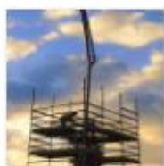
41.- Hormigonando en las nubes
