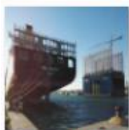
7.- Ejecución de cajones
