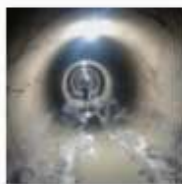
34.- Obra Tubería entre Presa de Charco Redondo
