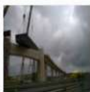
2.- Viaducto del AVE, izado
