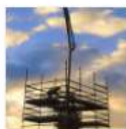
41.- Hormigonando en las nubes
