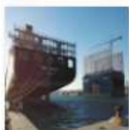
7.- Ejecución de cajones
