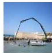
35.- Hormigonado cajones muelle S.Petri
