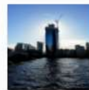
24.- Construction a la orilla del Tâmesis
