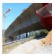
3.- Viaducto sobre el río Narcea 1
