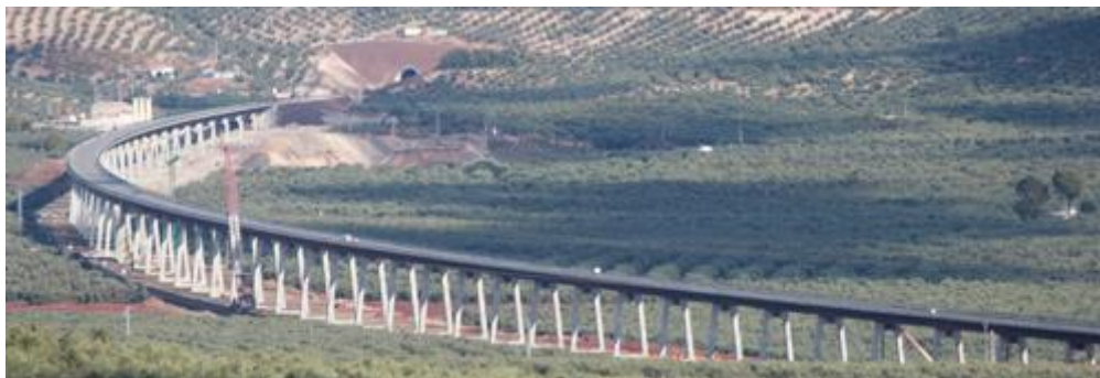
Fig. 11. Viaducto de Archidona en la línea Antequera-Granada. Fuente: ADIF.
